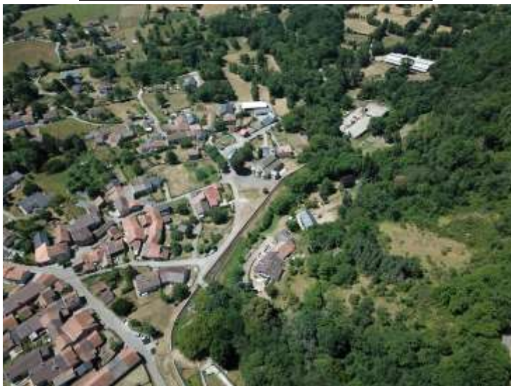
Photographie du système d'endiguement de Verdun
