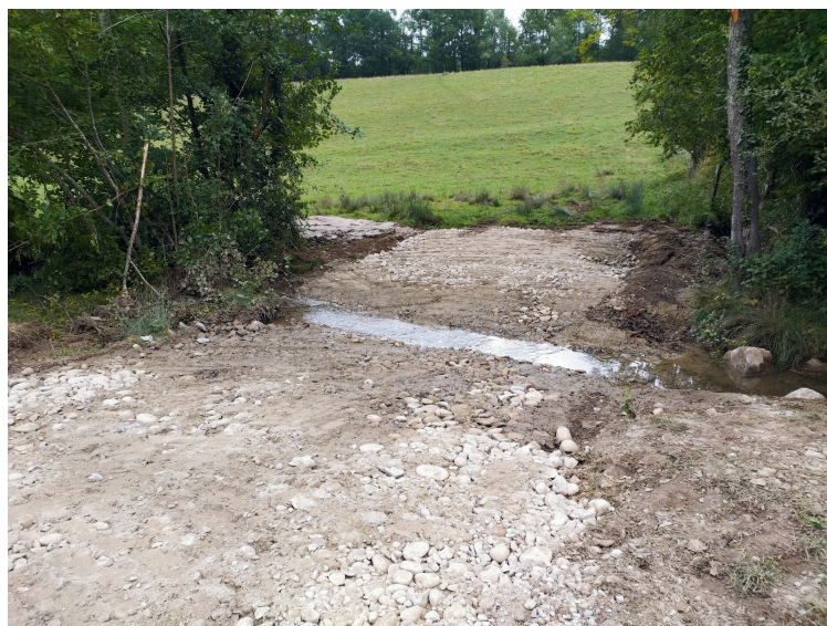
Le cours d'eau après les travaux d'aménagement
