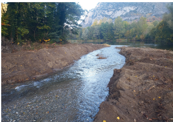
Réouverture d'un bras secondaire de l'Ariège à Ornodac-Ussat-les-Bains pour lutter contre l'érosion de berge
